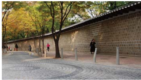
[예시] 덕수궁 돌담길. 보행자 중심의 보차공존도로 출처: 이혜선, "덕수궁 돌담길 시립미술관", 건축도시정책정보 센터 국내동향, www.aurum.re.kr
