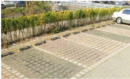
[사례] 주차장 잔디블록(청계산 공영주차장)
